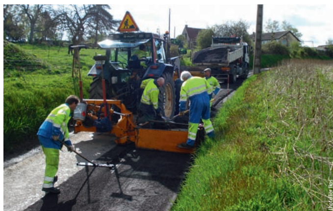
Photo 4 Réglage de la GE par l'appareillage de nivellement porté sur l'arrière du tracteur, avec accompagnement par l'équipe des services techniques communautaires de la CCAE Adjustment of emulsion-treated roadbase by levelling system carried on rear of tractor, accompanied by crew of CCAE community technical services
