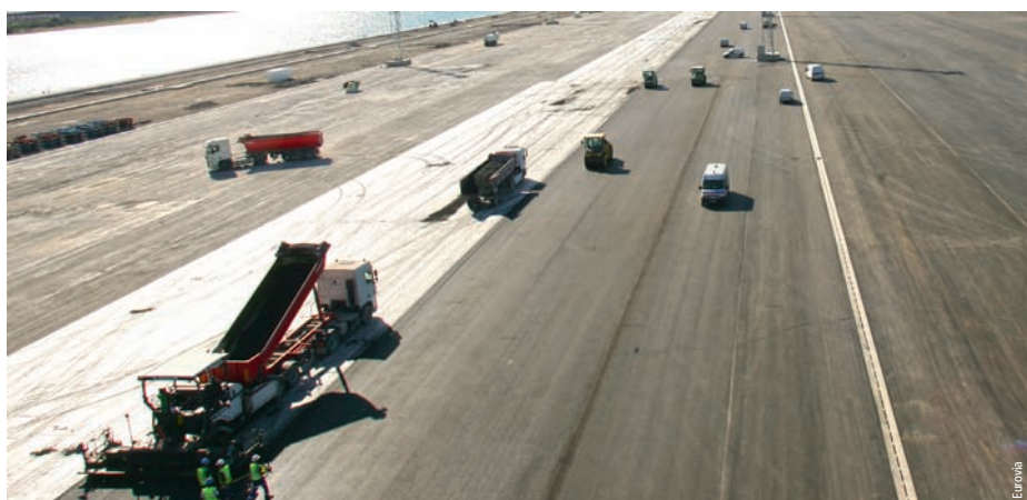
Photo 5 Atelier de mise en œuvre Application equipment
