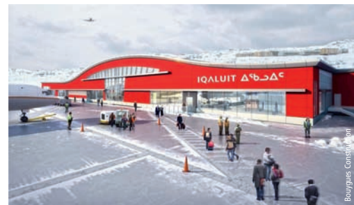
Le futur terminal aéroportuaire d'Iqaluit
