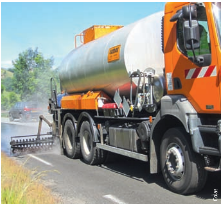
Photos 11 à 13 RD 926 Murat
