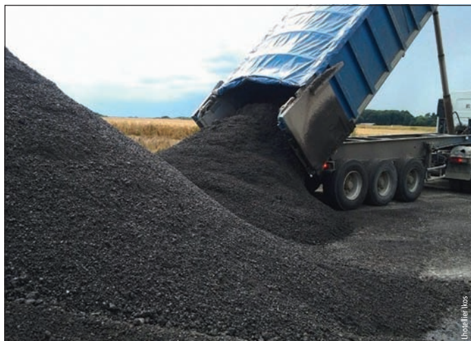
Photo 2 Mise en dépôt très provisoire de la GE avant rechargement sur des petits camions adaptés à l'accessibilité des chantiers (pour travaux de reprofilage sur la Communauté de communes du Bosc d'Eawy)
