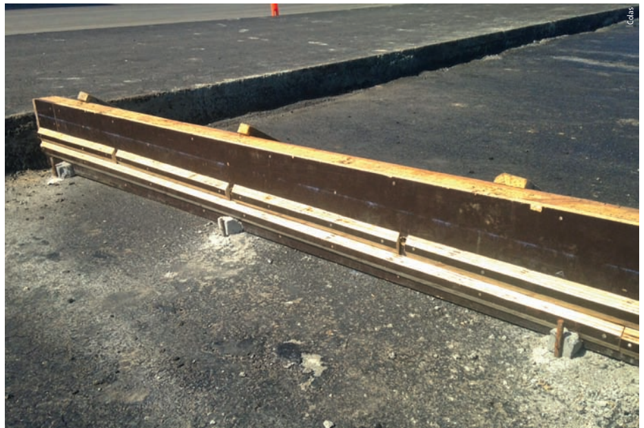
Photo 10 Détail des joints de construction Detail of construction joints
