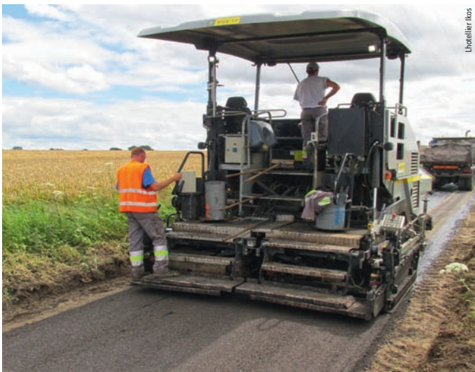
Photo 5 Mise en œuvre de la GE au finisseur (sur voie communale de La Crique dans la CCBE) Application of emulsion-treated roadbase (GE) by paver finisher (on La Crique communal roadway of Bosc d'Eawy CCBE)
