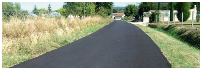
Photos 12a Aperçu après la mise en œuvre à Saint-Sylvestre-sur Lot Appearance after application
