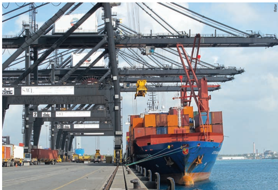
Photo 5 Vue d'un portique sur rails View of gantry crane on rails
