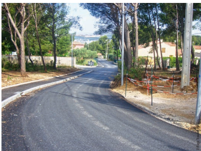
Photo 3 BIOCOLD® (formule B) – Voie communale à Rognac (13) BIOCOLD® (mix design B) – Communal road in Rognac (Bouches du Rhône region)
