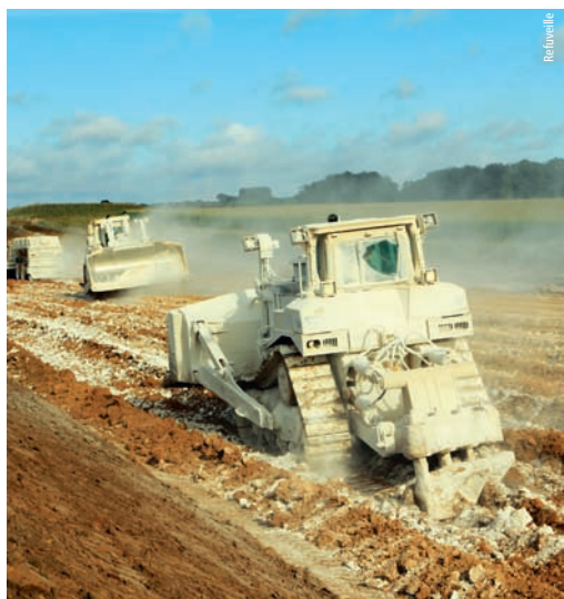
Chantier de construction de l'A150
