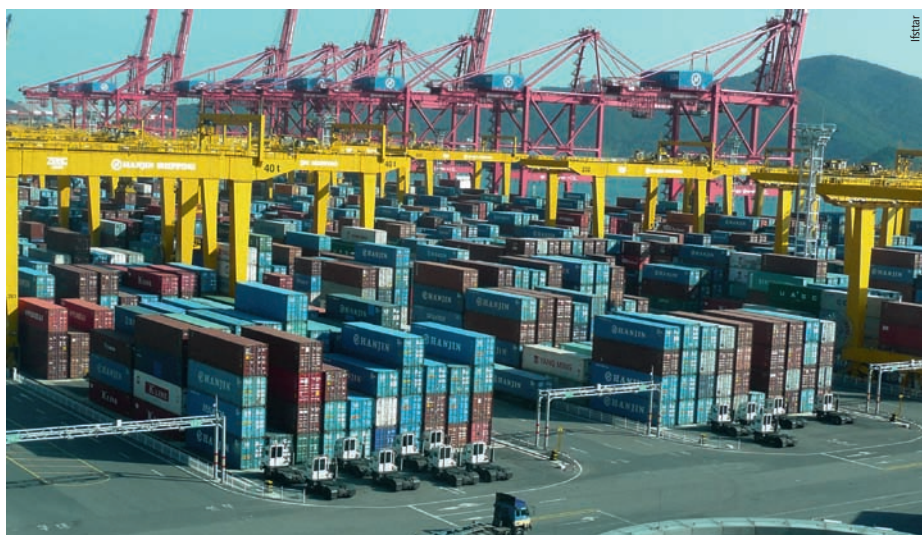
Vue d'ensemble d'une plate-forme logistique Overall view of a logistic platform
