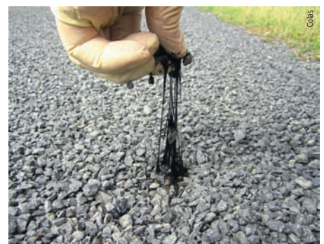
Photo 18 Procédé EMULCOL® (rampe côté répanduse)
