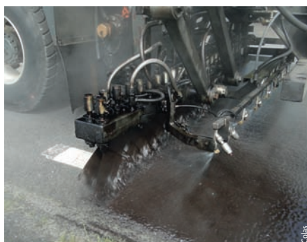
Photo 8 Application de l'enduit avec rupteur Chipseal laying with breaking agent
