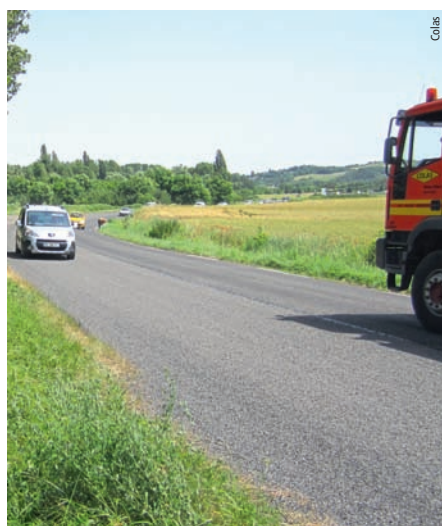
Photo 22 RD 213 Orcet sous circulation
