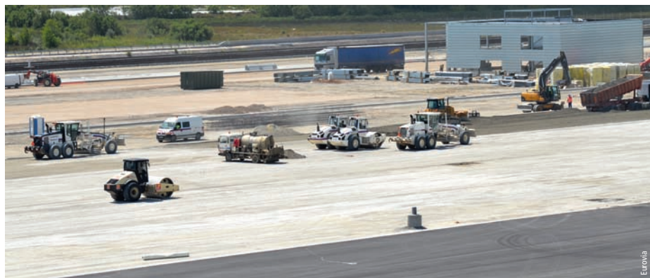
Photo 3 Atelier de mise en œuvre Application equipment
