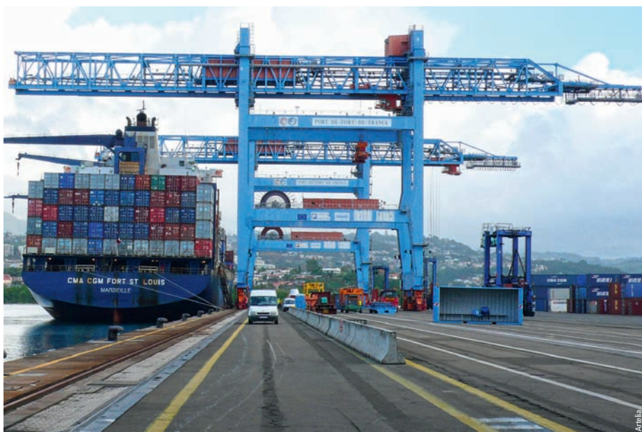
Photo 1 Terminal de la Pointe des Grives Pointe des Grives terminal
