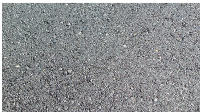
Photos 6 et 7 RD35 à Meyrals, aperçu après la mise en œuvre Appearance after application
