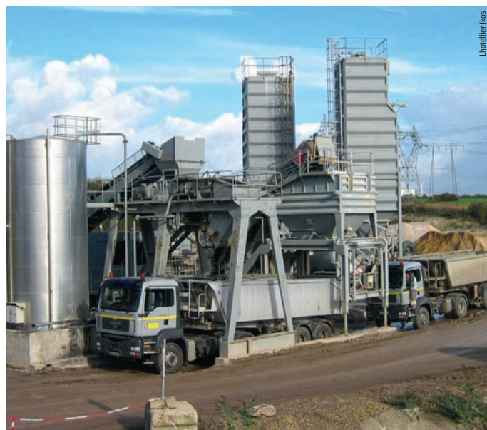
Photo 1 Centrale avec ligne spécifique d'enrobage à froid à l'émulsion de bitume, SAMOG à Argœuves (80) Mixing plant with specific cold-mix bitumen emulsion line, SAMOG in Argœuves (Somme region)
