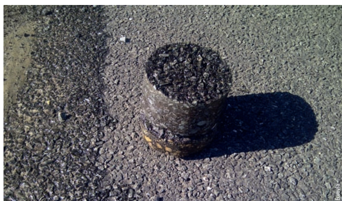
Photo 8 RD 35 à Meyrals, carottage à 23 mois Core sample after 23 months
