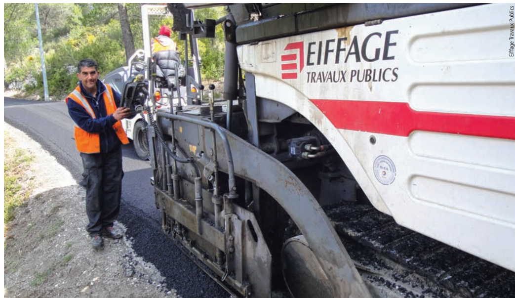
Mise en œuvre de l'enrobé Biocold sur la commune d'Auriol (13) Application of Biocold asphalt for the town of Auriol (Bouches du Rhône region)
