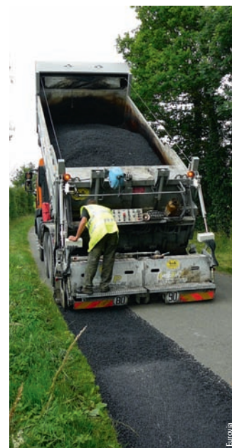
Photo 3 Reprofilage au finisseur d'intervention rapide (FIR) Resurfacing
