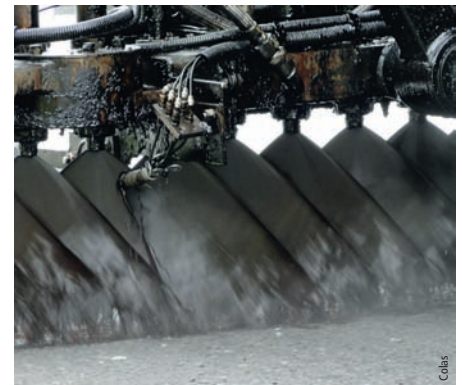
Photo 18 Procédé EMULCOL® (rampe côté répanduse)
