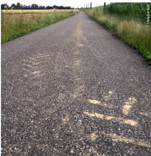
Photo 7 Aucune déformation au passage au très jeune âge sur la GE encore non revêtue No early-age traffic deformation on as-yet-unpaved GE roadbase
