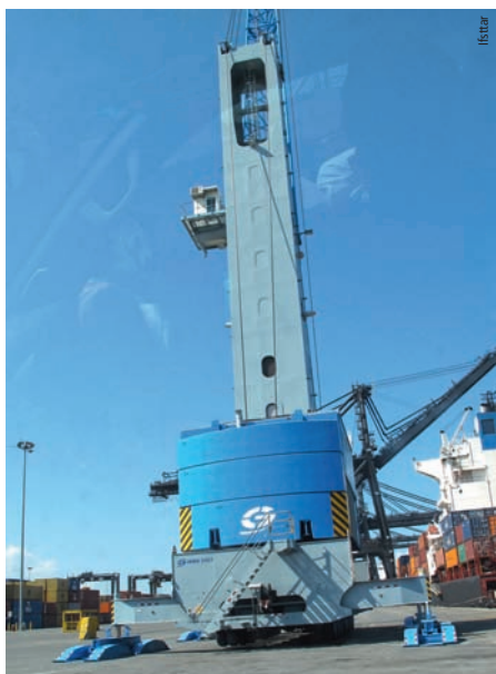
Photo 4 Vue d'une grue sur pneus en phase de manutention View of tyre-mounted crane in handling phase
