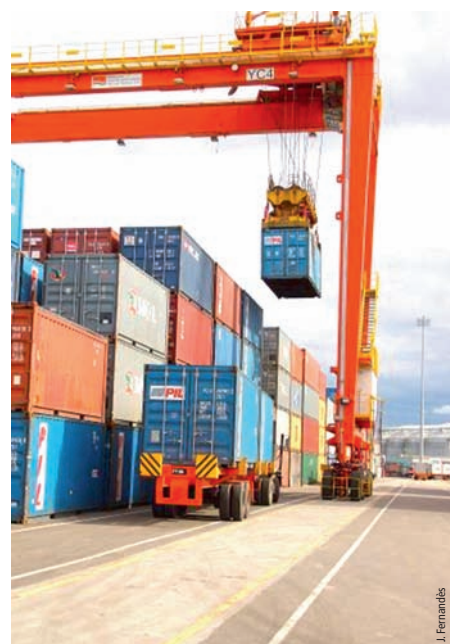
Photo 9 Voie RTG en béton RTG (gas turbine train) concrete track
