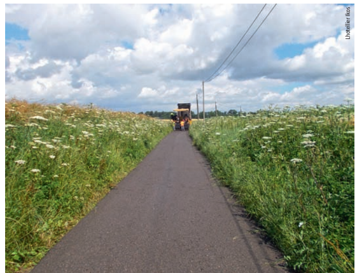
Photo 6 Aspect de la chaussée après la mise en œuvre de la GE au finisseur (sur voie communale de Grigneuseville dans la CCBE) Appearance of pavement after application of GE roadbase by paver finisher (on communal roadway of Grigneuseville in CCBE)
