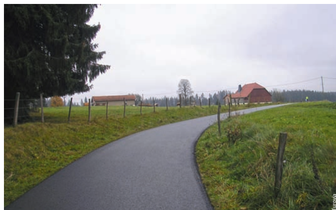
Photos 1 et 2 Voirie communale à Gilley avant et après réfection en Viasef C Fv Viasef C Fv - Before and after repair of communal roadway in Gilley (Doubs region)
