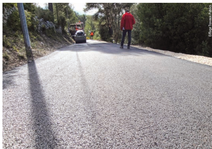
Photo 2 Aspect du BIOCOLD® (formule A) – Voie communale à Auriol (13) Appearance of BIOCOLD® (mix design A) – Communal road in Auriol (Bouches du Rhône region)
