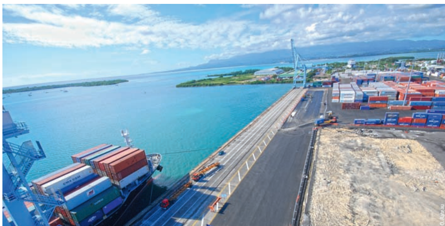
Photo 1 Vue générale du port de Jarry (Guadeloupe) General view of Jarry port
