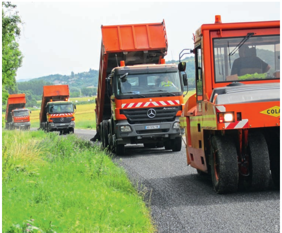
Photo 1 Chantier ESU à l'émulsion HP à Orcet (63) en juin 2012 HP emulsion job site at Orcet (63) - june 2012
