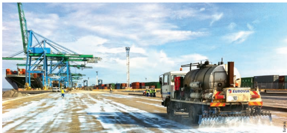
Photo 4 Répandage du produit de cure Spraying of curing product
