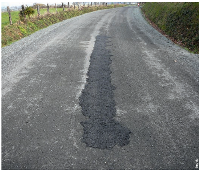
Photo 4 Réparations localisées Local repairs
