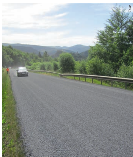
Photo 21 RD 926 Murat sous circulation
