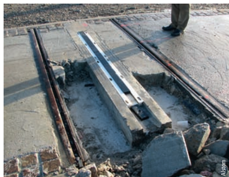
Photo 6 Poutre béton Concrete beam
