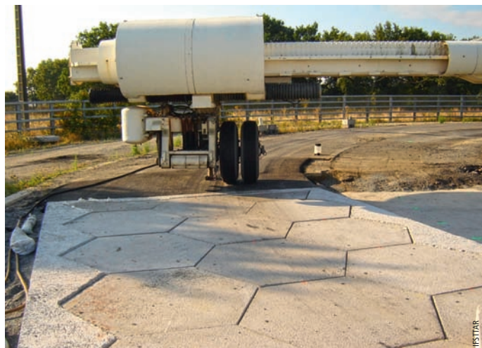
Tronçon de CUD à dalles indépendantes, sur le manège de l'Ifsttar, soumis au passage de jumelages de 6,5 tonnes
