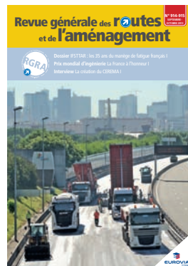
Réfection de l'A14 Crédit photo : Photothèque Eurovia/ Axel Heise www.eurovia.com
