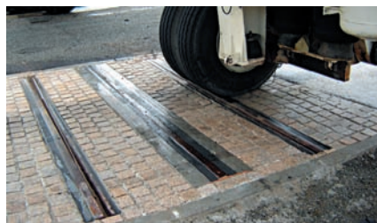
Test de chaussées de tramway
