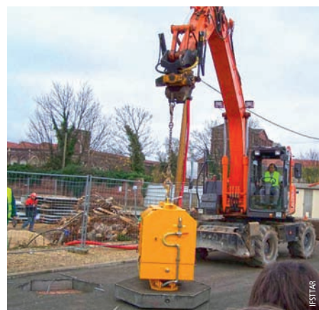
Photo 5 Démontage de la CUD de Saint-Aubin-lès-Elbeuf
