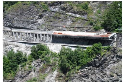
Réfection de la casquette en béton sur la RN 205
