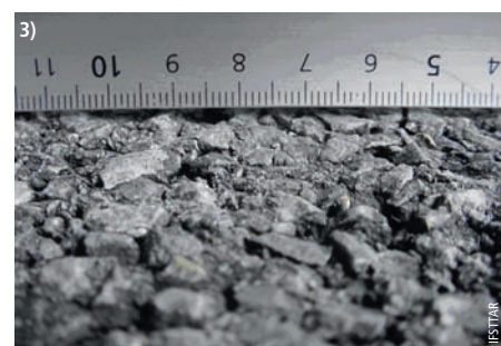
Photos 1 à 3 Détails des surfaces en fin d'essai du BBSG 0/14 (1), du BBTM 0/10 (2) et du BBTM 0/6 (3), après 800 000 passages de tandem à roues simples Details after tests on semi-coarse asphalt (BBSG 0/14) and very thin asphalts (BBTM 1/10 and BBTM 1/6) after 800,000 passages of single-wheel tandem
