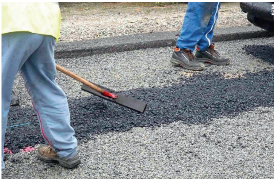
Photo 7 Fibre recouverte d'enrobé Asphalt covering over fibre
