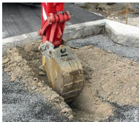
Photo 3 Réalisation aisée d'une tranchée dans la grave-ciment excavable, à l'aide d'une pelle mécanique
