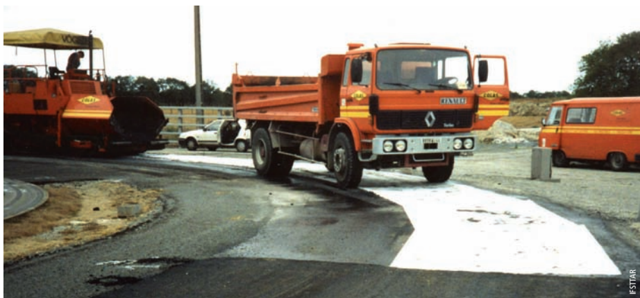
Mise en place d'un COLGRILL® (membrane renforcée en fibre de verre) sur le manège
