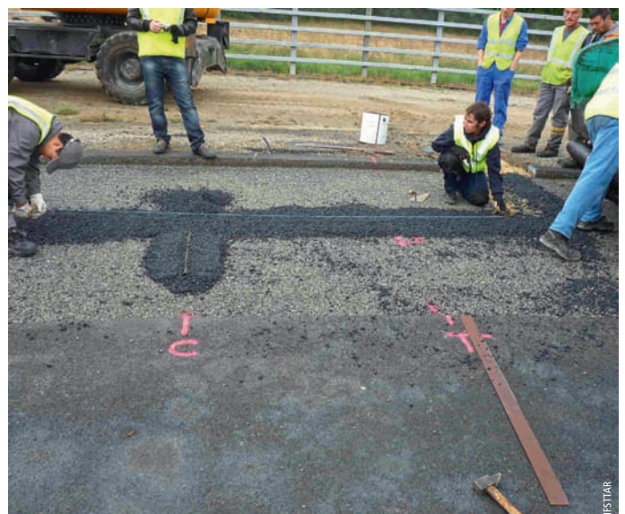
Photo 6 Mise en place des fibres optiques continues Placing of fibre
