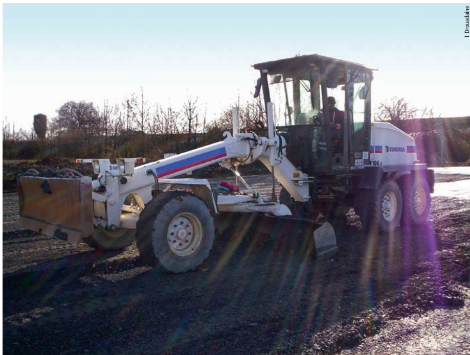
Mise en œuvre de Scorgrave à la niveleuse Laydown of Scorgrave by grader
