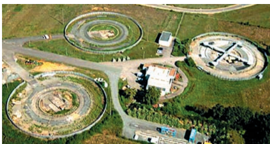
Vue aérienne des trois pistes d'essai
