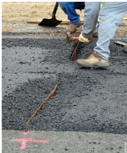
Photo 3 Installation des deux plaques métalliques après le passage du finisseur Installation of two steel plates after passage of paver
