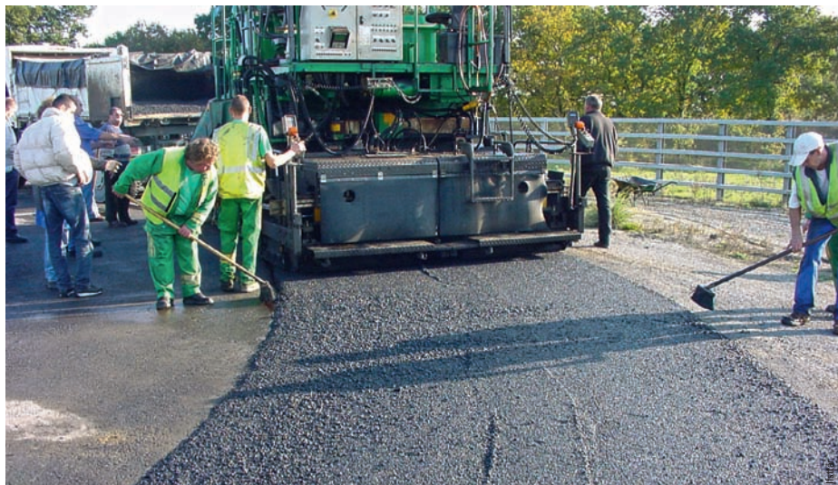
Répandage d'un BBTM sur le manège de fatigue Placing a very thin asphalt concrete on fatigue test track
