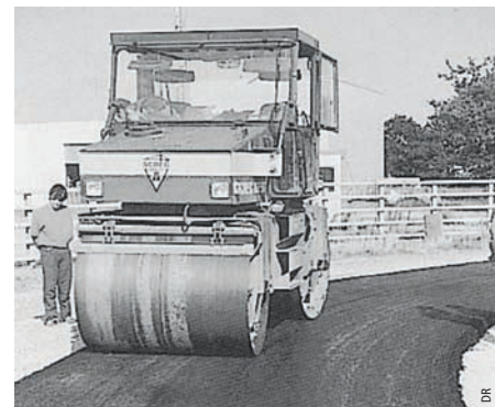
Photos 1 et 2 Compactage du Compomac M2
