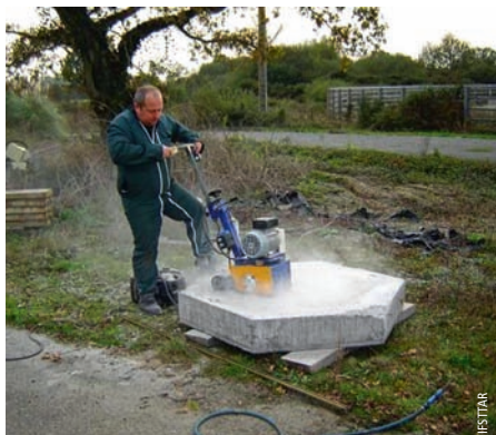
Photo 2 Rabotage de la partie centrale inférieure des dalles prototypes CUD
