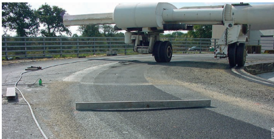
Orniéragé d'une structure souple sur le manège de fatigue Rutting of a flexible structure on fatigue test track
