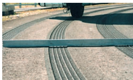
Orniéage d'une structure (trafic canalisé)
