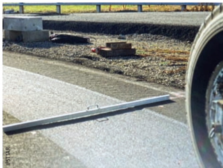
Photo 5 Orniérage du BB (Superpave) après 200 000 chargements de 65 kN Rutting of asphalt (Superpave) after 200,000 loads of 65 kN
