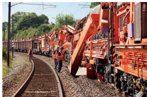
Renouvellement de la voie ferrée entre Saint-Hilaire et Hagondange, avec remplacement du ballast, des rails et des traverses, au moyen de la Suite Rapide
