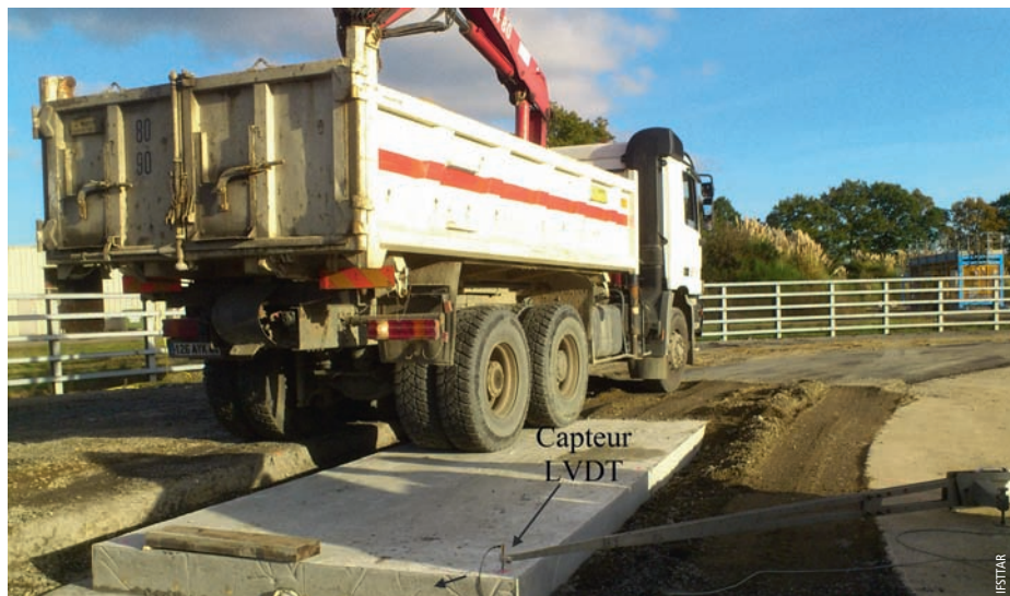
Photo 3 Vérification de la solution de stabilisation des dalles Checking of slab stabilisation solution
