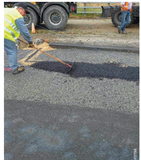
Photo 4 Réalisation manuelle d'un tapis d'enrobé Covering with asphalt mat
