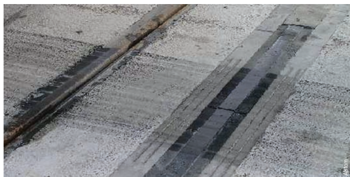
Photo 2 Poutre béton rail métallique revêtement béton Concrete beam, steel rail, concrete surfacing
