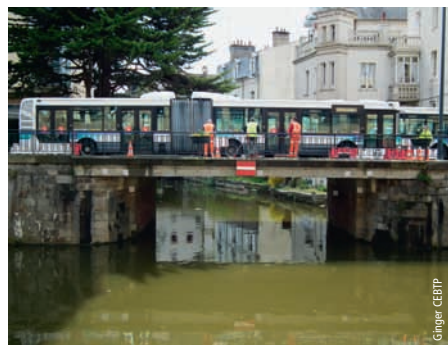
Le pont Richemont
