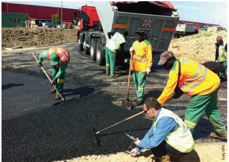
Mise en œuvre manuelle d'un enrobé
