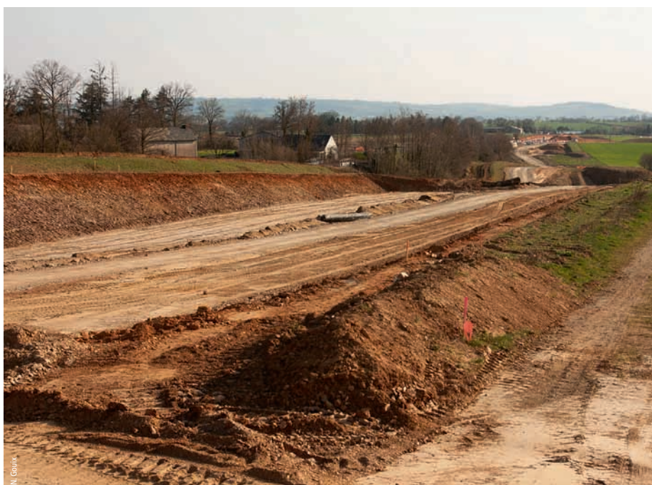
Photo 3 Chantier de la mise à 2 x 2 voies de la RN 88
