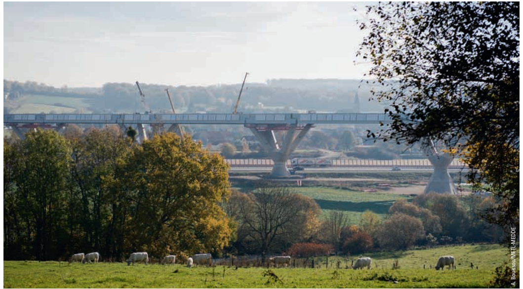
Chantier LGV Rhin-Rhône : viaduc de La Savoureuse
