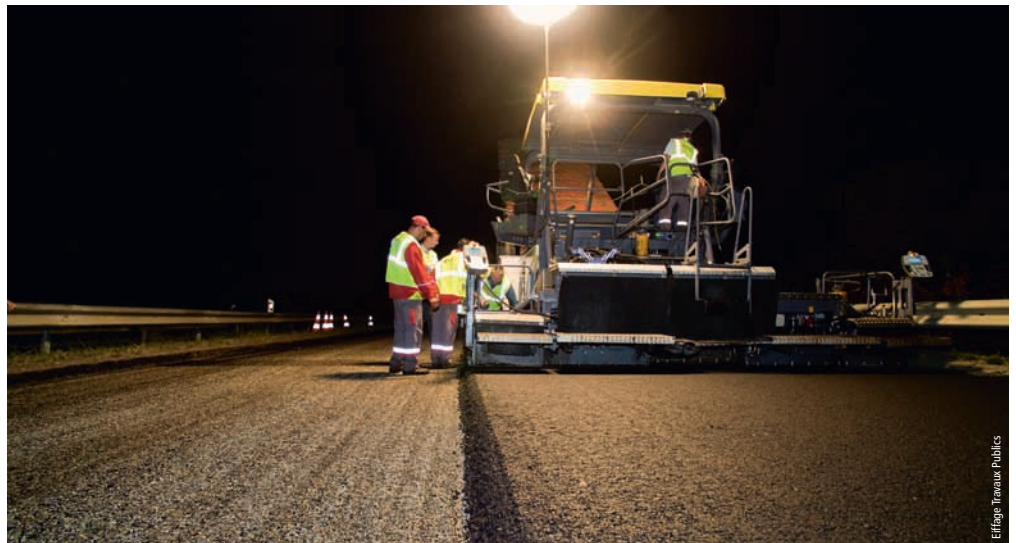
Mise en œuvre des EBT sur RD 817
