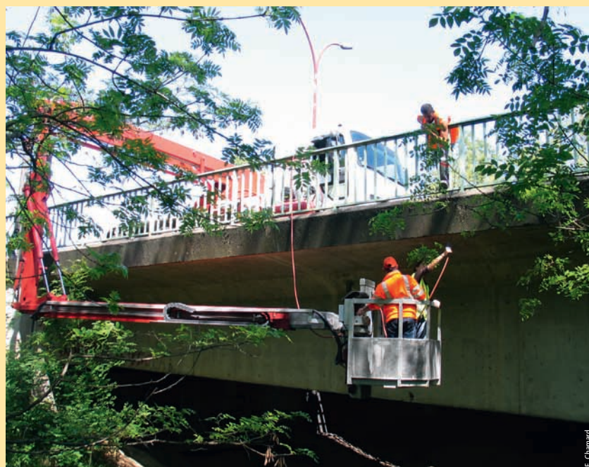
Etude chiroptérologique d'un ouvrage d'art géré par la DIR à réparer, inspection au moyen d'une nacelle par le Conservatoire d'espaces naturels de Midi-Pyrénées
