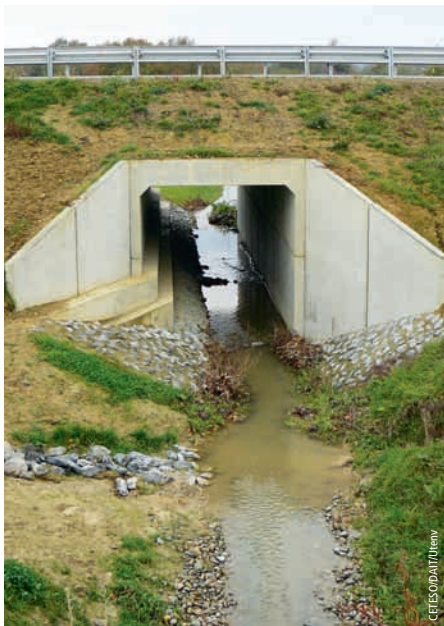
Photo 2 Ouvrage de franchissement hydraulique aménagé de banquettes
