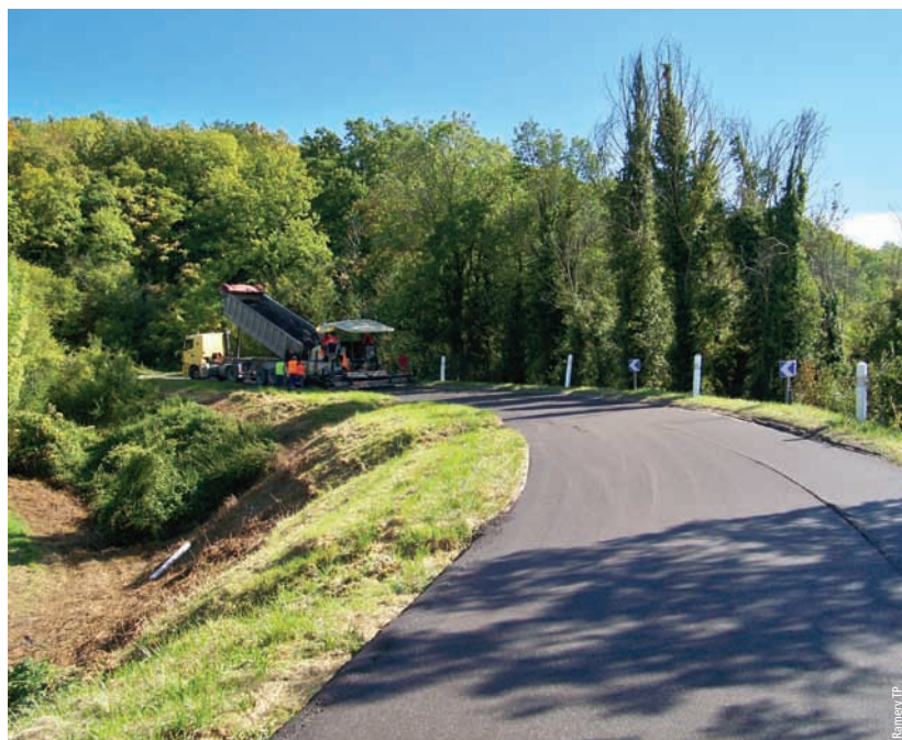
Mise en œuvre de grave Emulpave sur la RD55 à Caucigny (60)
