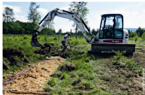
Travaux de fermeture d'un fossé
