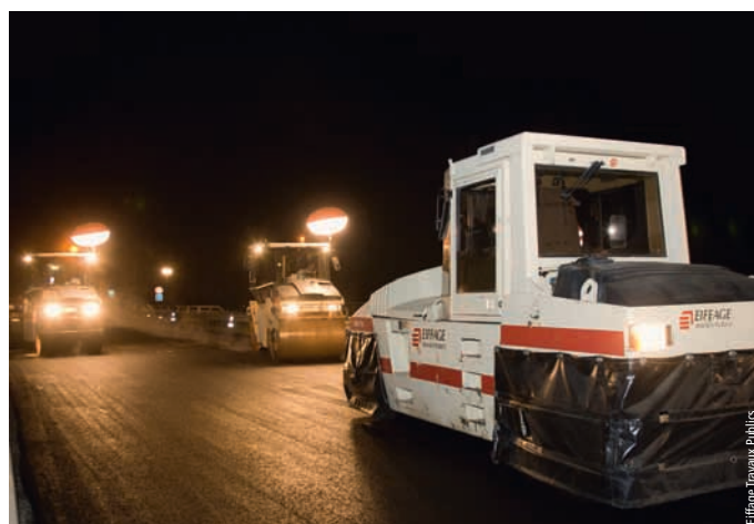
Vue générale du chantier
