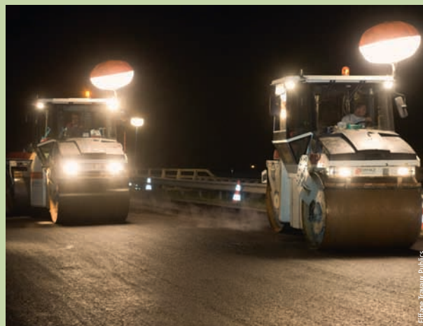
Compactage des EBT sur RD 817
