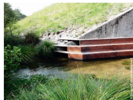
Photo 2 Rétablissement des cheminements petite faune sous un ouvrage hydraulique de l'A63 par des banquettes en structure bois/inox
