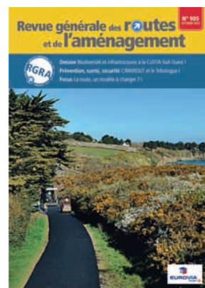
Mise en oeuvre d'enrobés tièdes à Belle-Ile-en-Mer (56) Crédit photo : photothèque Eurovia / Axel Heise
