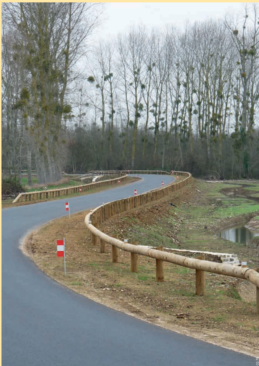
Photo 1 Rectification des virages sur la RD 103
