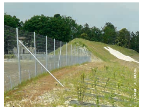
Photo 9 Merlon acoustique bordant une autoroute
