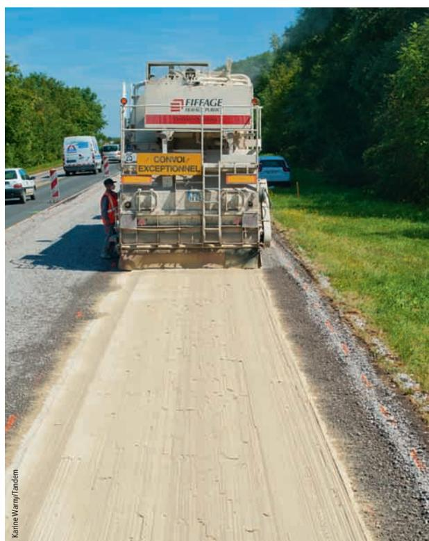
ARC dosage en cours de répandage du liant hydraulique
