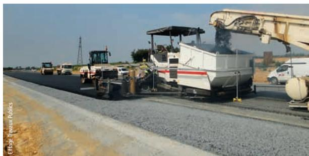
Mise en œuvre de l'enrobé GB5 au Biprène sur A813
