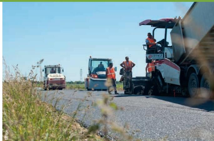
Mise en œuvre du Biocold dans le département de la Sarthe
