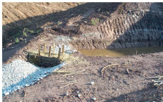
Filtre à paille en aval d'un bassin provisoire
