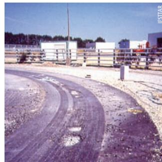
Photo 3 Formation de nids-de-poule suite à l'accumulation d'eau à l'interface entre l'assise en matériau traité au liant hydraulique et la couche de roulement
