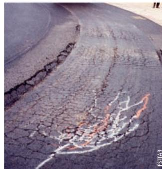
Photo 2 Dégradations liées aux infiltrations d'eau sur une chaussée à faible trafic, à assise en GNT polluée, sensible à l'eau (expérience de 1990)
