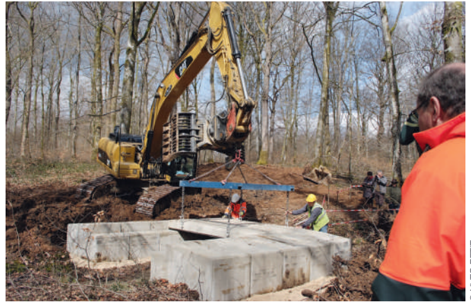
-Photo 8- Travaux du ponceau modulable.
